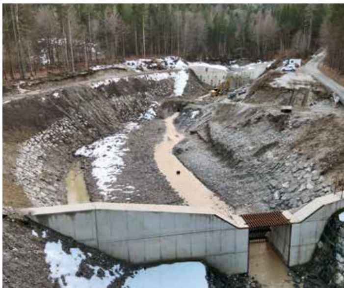
Blick auf das neu errichtete Geschieberückhaltebecken im Oberlauf des Rotschitzabaches. Das Bauwerk kann rund 26.000 Kubikmeter Geröll und Schotter aufnehmen und ist ein zentraler Bestandteil des Hochwasserschutzprojekts der Marktgemeinde Finkenstein am Faaker See.
