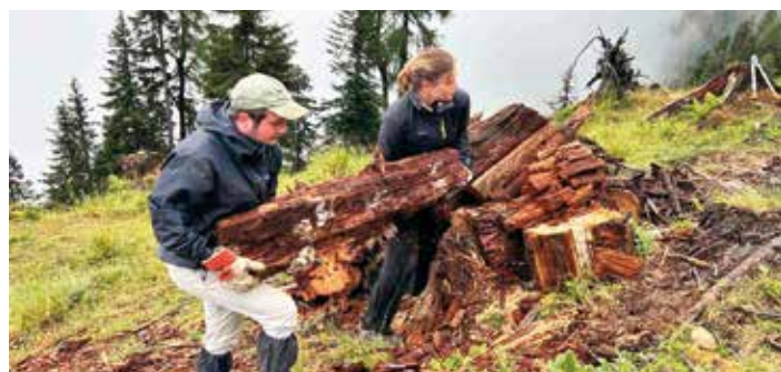
Flo und Alisa beim Entfernen einer alten Kuhtränke.
