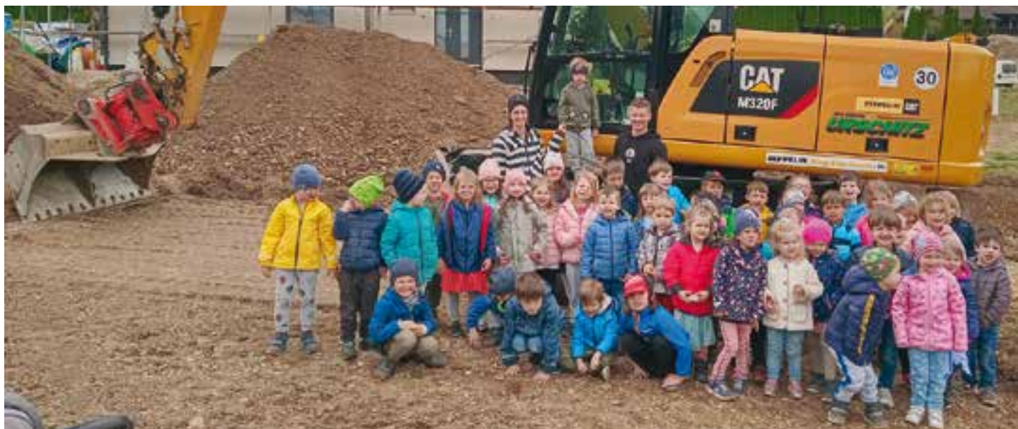
Die Kinder erlebten eine aufregende Zeit auf der Baustelle bei Familie Urschitz.
